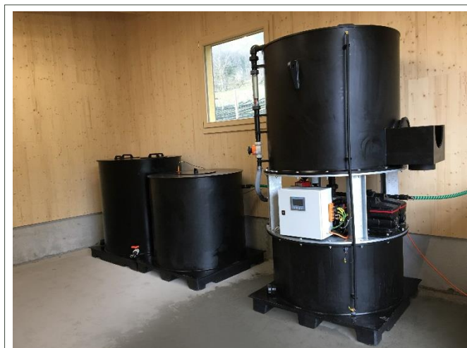
Système de filtration à charbon actif avec le module de filtration des particules (conteneur à gauche), le réservoir de stockage en aval (centre) et le module PPh avec le charbon actif (colonne à droite). Photo: S. Schäfer.
