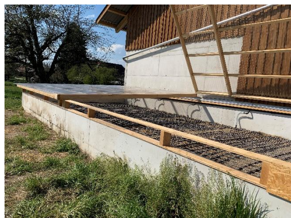
Fig. 3: Enceinte en béton avec système d'arrosage Phytobac® (Image: U.Wyss AG).
