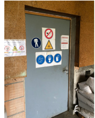
Le local de stockage est fermé à clé ; la signalisation est en place.
